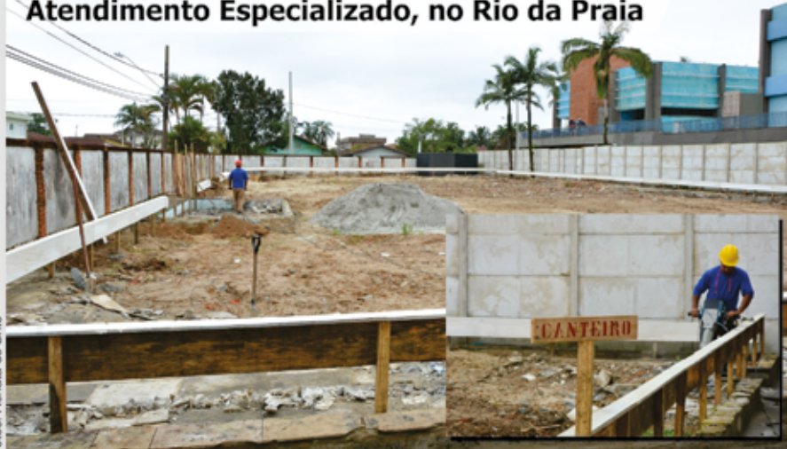
Construção da U.A.E. - Unidade de Atendimento Especializado, no Rio da Praia
