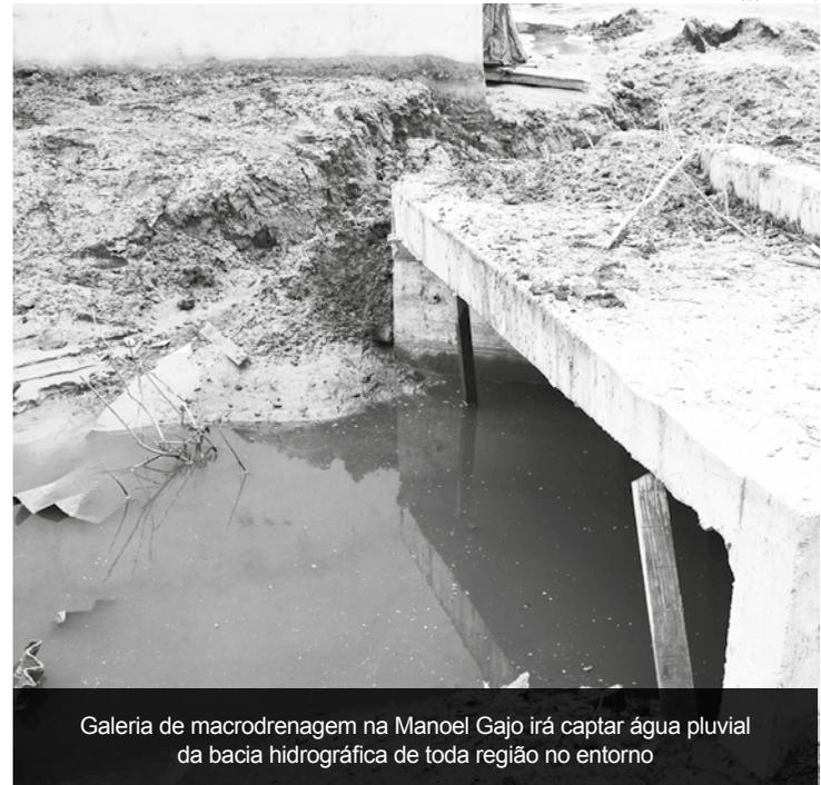
Galeria de macrodrenagem na Manoel Gajo irá captar água pluvial da bacia hidrográfica de toda região no entorno
