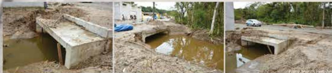
Agora, a frente de trabalho está empenhada nos serviços da galeria de macrodrenagem, que conta com 377 metros de comprimento, 2,90 metros de largura e 2 metros de profundidade. A galeria irá captar água pluvial da bacia hidrográfica de toda região no entorno. Assim, a pavimentação será concluída até a Rod. Rio-Santos.
