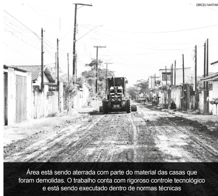
Área está sendo aterrada com parte do material das casas que foram demolidas. O trabalho conta com rigoroso controle tecnológico e está sendo executado dentro de normas técnicas
