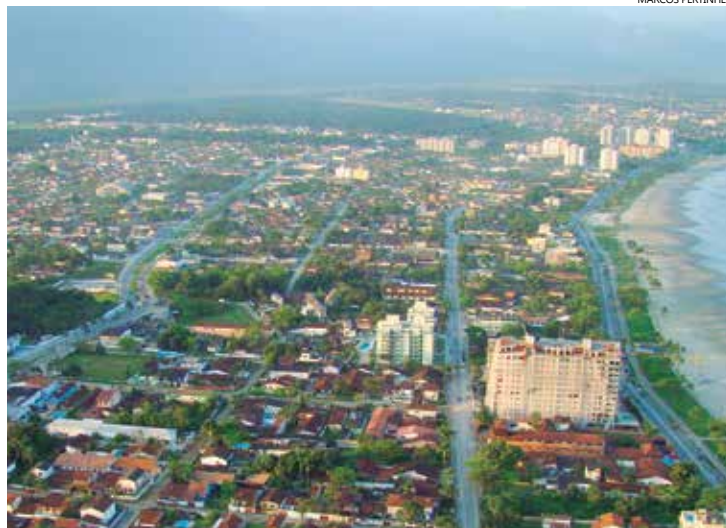
Das duas vias receberão importantes intervenções de macrodrenagem. A Rua Manoel Gajo, no trecho entre as ruas Ayrton Senna e Edmundo Gomes, no Centro, Rua José Toledo Civitanova, no Maitinga
