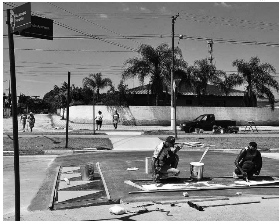
Entre as ações de segurança e educação de trânsito, no Município, para contribuir com a redução de acidentes, se destaca a implantação de lombofaixas ao longo da Avenida Anchieta
