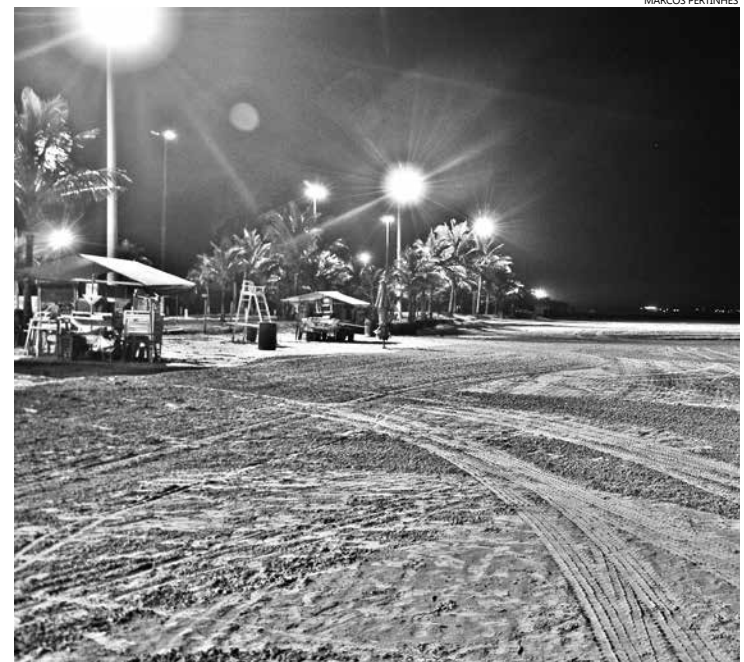
A iluminação desportiva da orla está sendo instalada em sete bairros, com recursos provenientes da Contribuição de Iluminação Pública (CIP), instituída em Bertioga em junho de 2013
