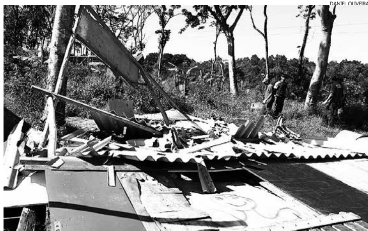
Ação ocorreu no Bairro Chácaras, onde foram demolidas duas submoradias, que estavam abandonadas
