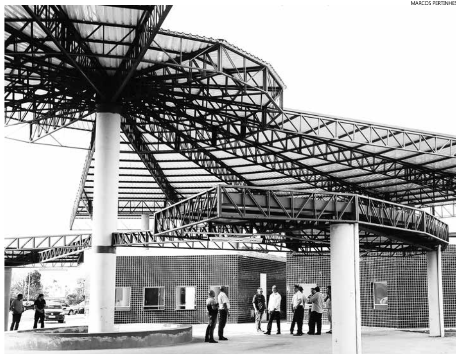
Rodoviária recebeu investimento de um pouco mais de R$ 1,48 milhão, sendo R$ 1 milhão proveniente de convênio com o Estado
