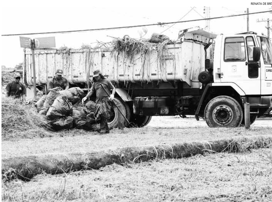
Equipe realiza roçada, limpeza de valas, nivelamento de ruas e desobstrução de tubulação de drenagem
