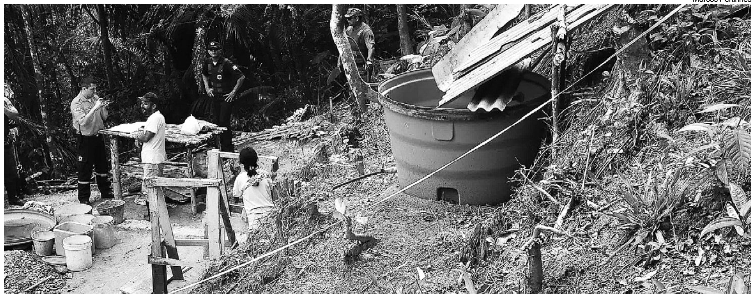
A DOA atuou também na contenção de áreas de preservação
