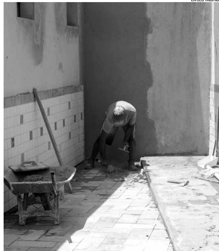
Cerca de 90% dos serviços realizados no prédio já foram concluídos
