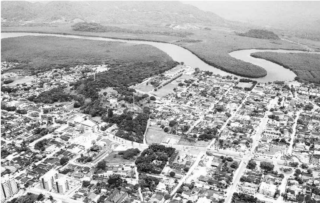
As ruas que serão beneficiadas estão localizadas na região central e já contam com redes de água, esgoto e drenagem
