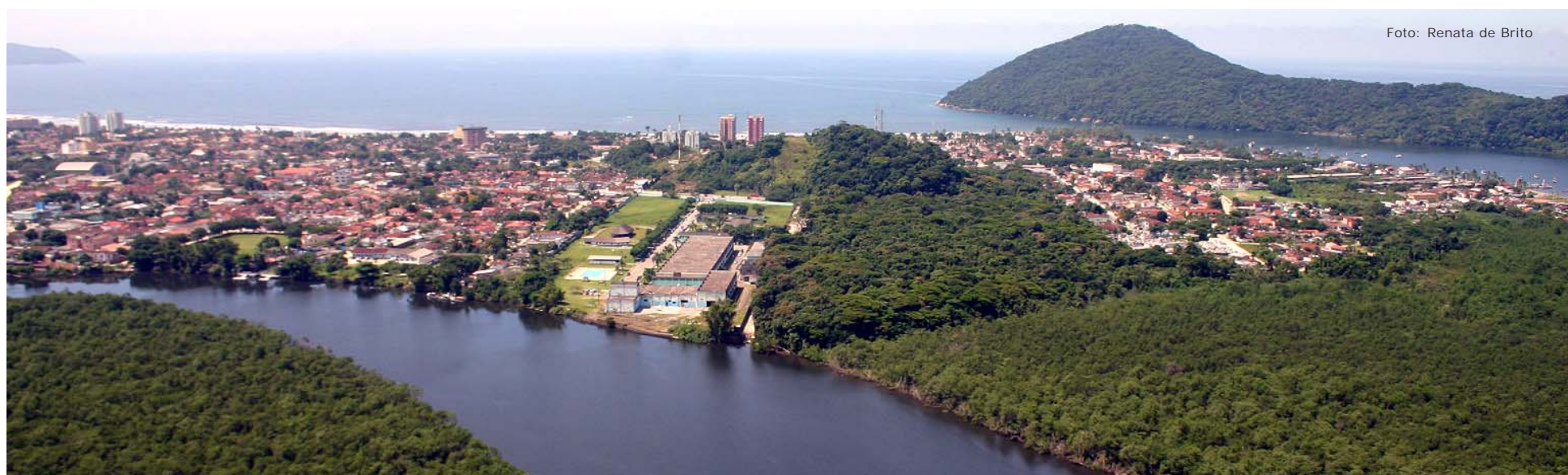
O Rio Itapanhaú facilita o transporte das plataformas e também o recebimento de materiais e equipamentos
