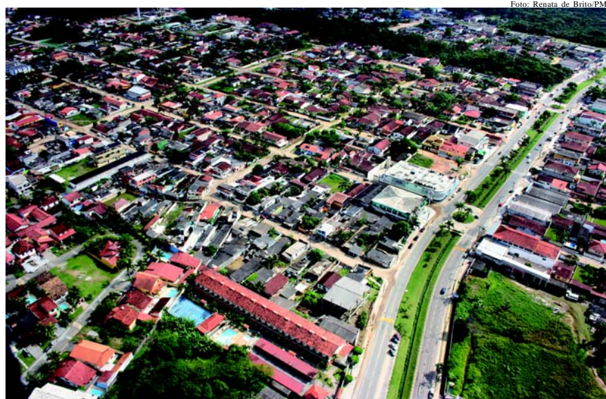
Obras beneficiarão 11 loteamentos da região central, entre eles o Jardim Paulista
