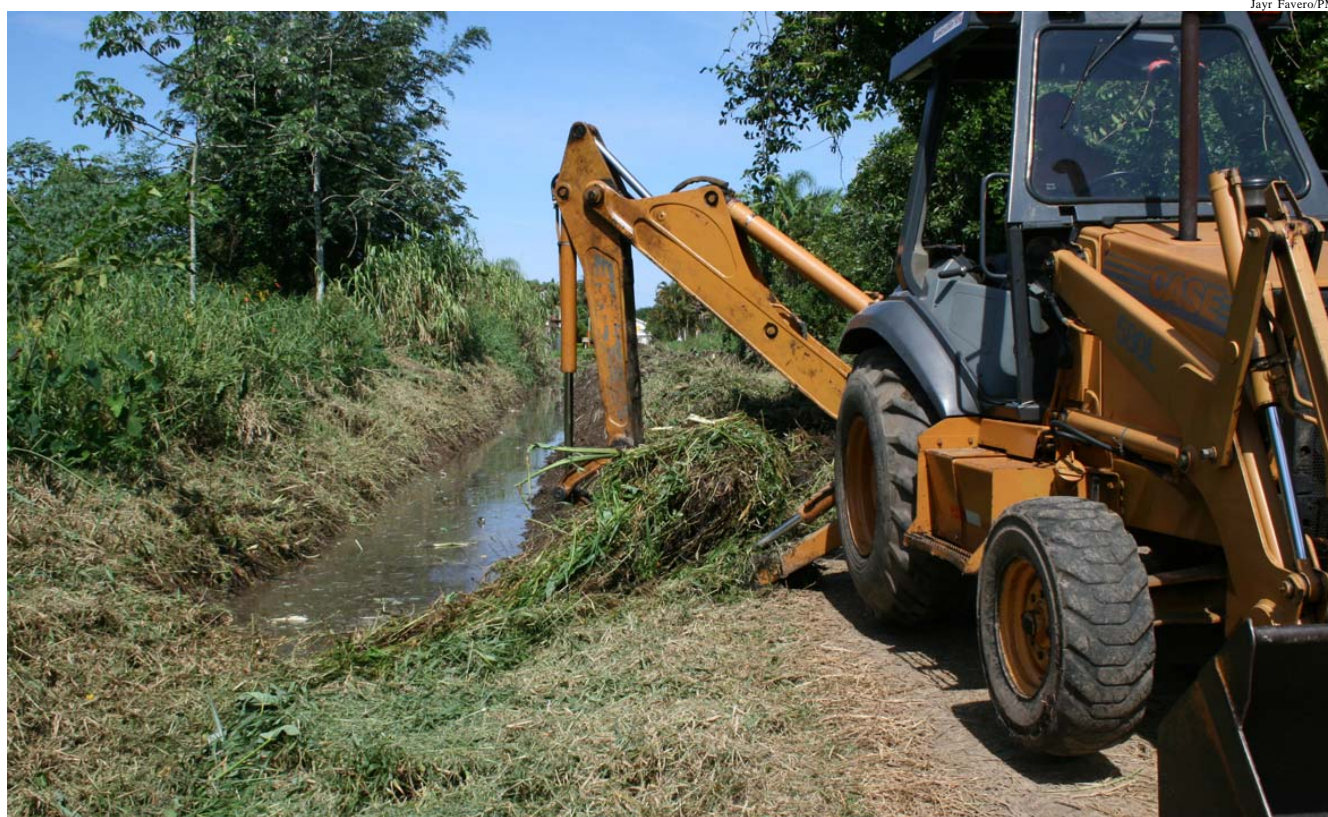
Equipamentos da Prefeitura percorrem todas as ruas do Indaiá para efetuar limpeza de valas
