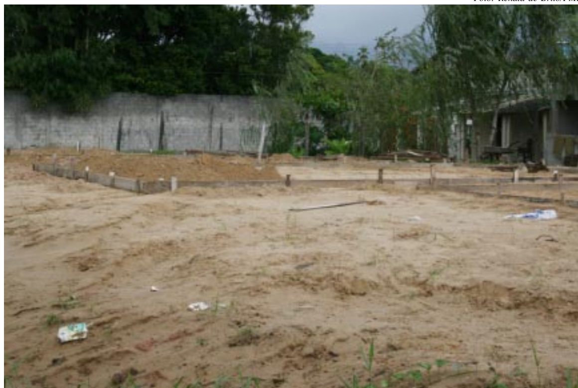
Área pública tem 1.564,98 m 2 : casas serão construídas em sistema de embrião de 25 m 2 para remover famílias do Ilha 2
