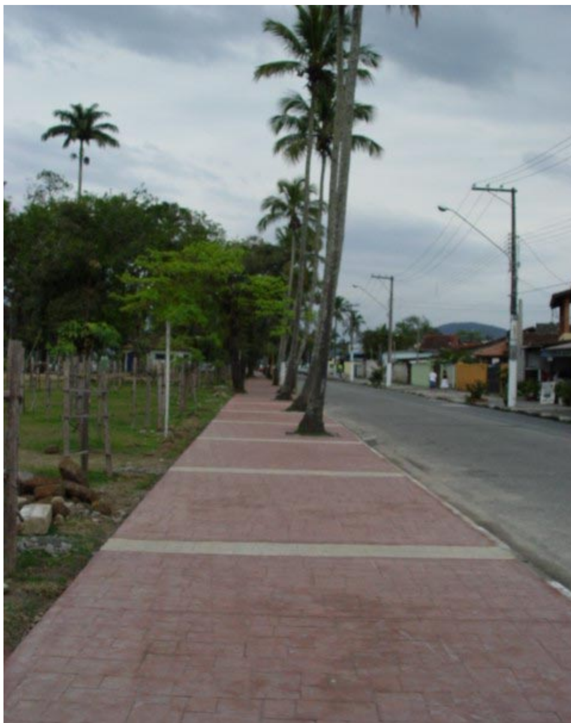
Obras no entorno do Forte São João transformaram a paisagem de um dos mais importantes cartões-postais da cidade
